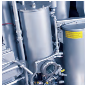
Wartungsfrei: der selbst- reinigende Wasserabscheider
